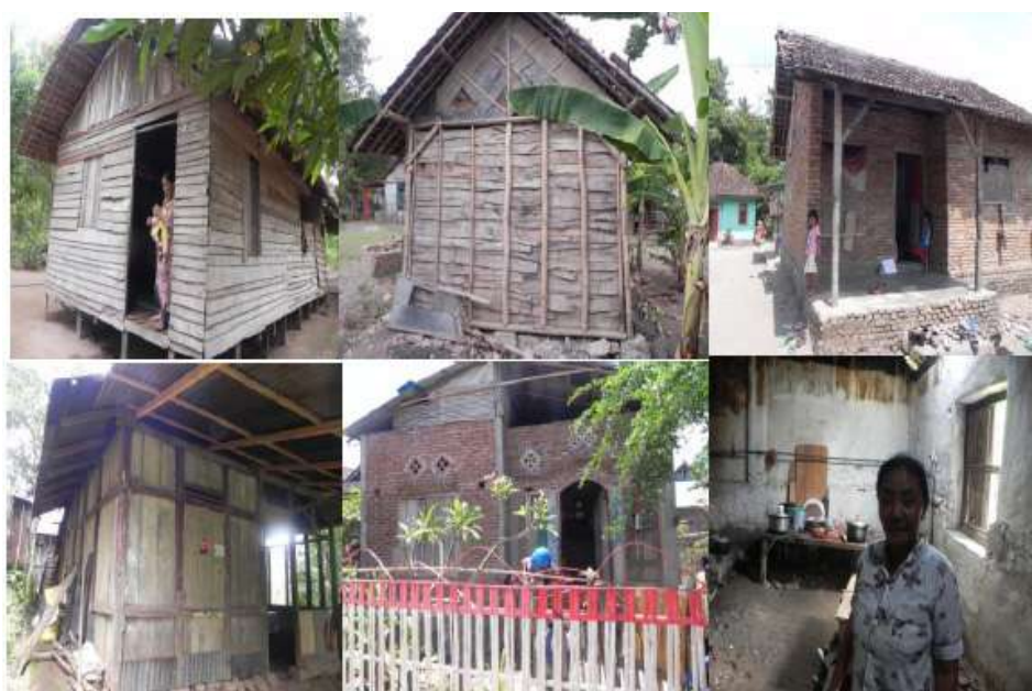
Gambar 5.1. Kondisi RTSM di Berbagai Wilayah
